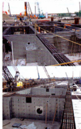
浦安市/小学校新設工事
